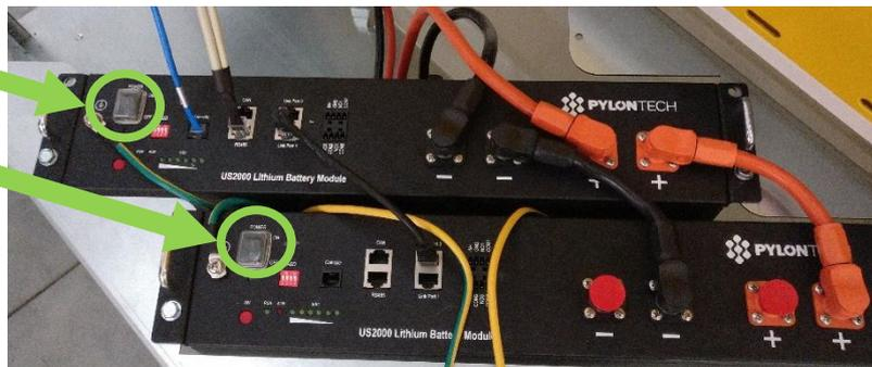
Figura 58 - Spostare su "0" gli interruttori "0/1" di tutti i moduli batteria
