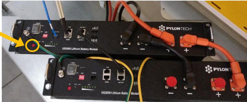
Figura 57 - premere il pulsante SW solo della batteria più in alto
