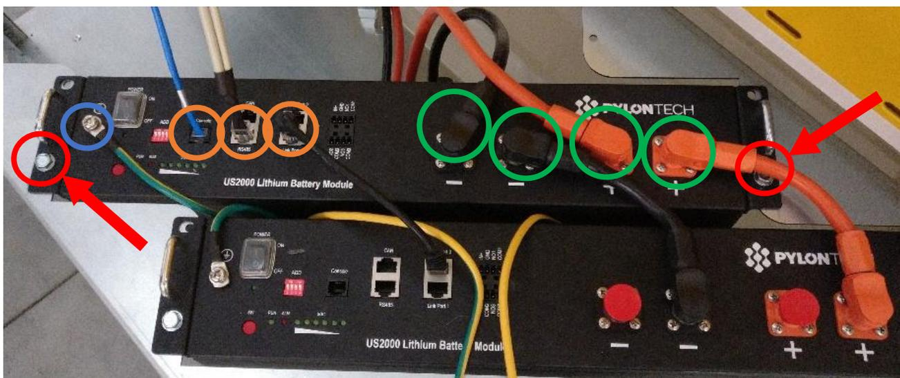
Figura 54 - Sostituzione modulo batteria - Rimozione viti fissaggio modulo, vite collegamento equipotenziale, cablaggi di segnale e potenza
