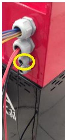
Figura 18 - Installazione pressacavo per cavo CT
